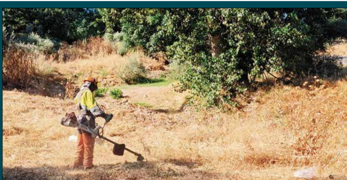
Los trabajos de desbroce llegan al entorno de La Bastida. Se están llevando a cabo trabajos de desbroce y limpieza vegetal, como el parque periurbano de La Bastida, en donde se encuentra trabajando una cuadrilla formada por cuatro operarios.
