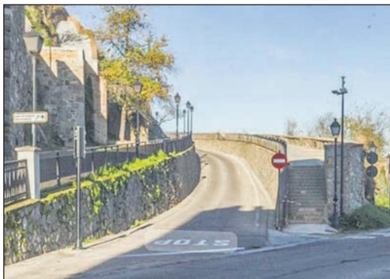
Las obras, que dieron comienzo el lunes 10 de febrero, se prolongarán durante cinco semanas.
