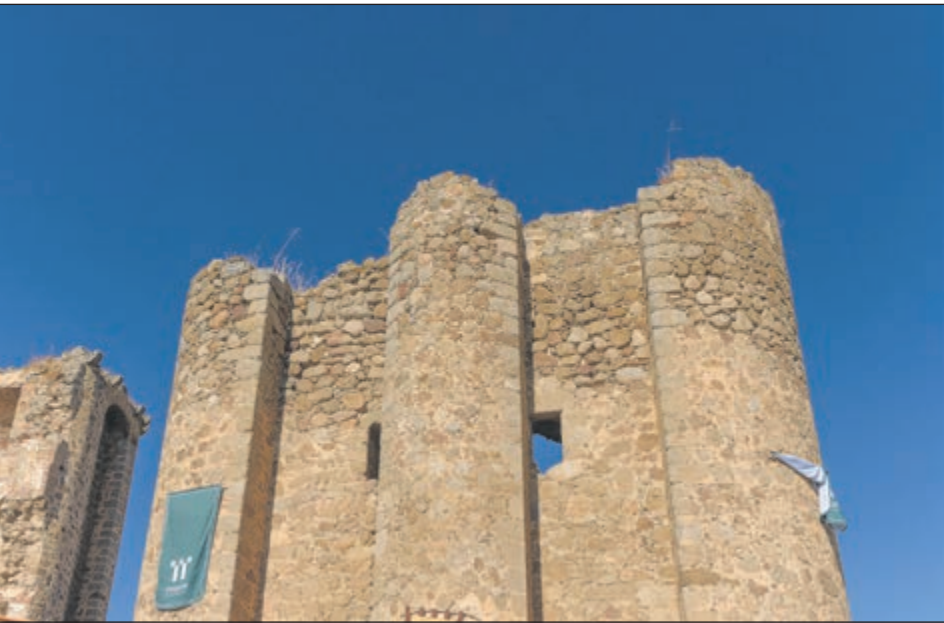
Lo que confiere al castillo de Polán un carácter excepcional son sus rasgos arquitectónicos, que lo diferencian de la mayoría de las fortalezas castellanas de su tiempo. La característica más distintiva son los contrafuertes o estribos exteriores curvos que refuerzan las torres, asemejando un pilar central rodeado de columnas adosadas.
