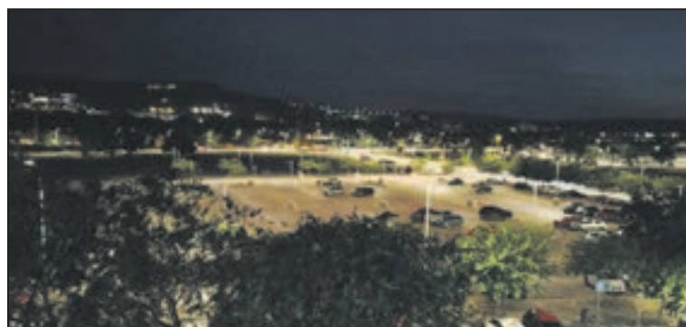
Aspecto de la nueva iluminación en la zona.
