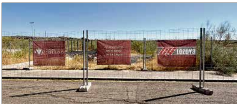
Parcela en la que se situará el nuevo aparcamiento.
