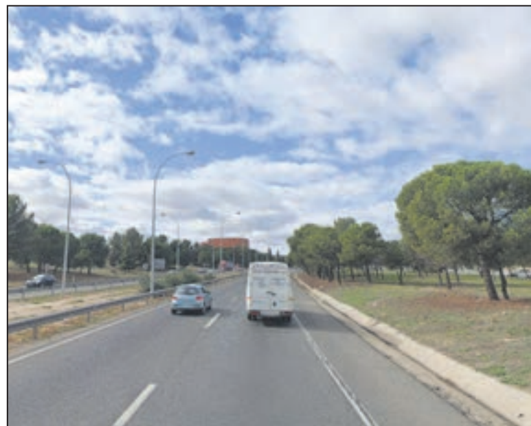
El nuevo tercer carril de la TO-23 reorganizará los accesos al Polígono.
